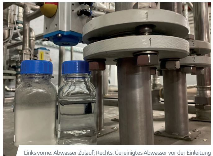
Links vorne: Abwasser-Zulauf; Rechts: Gereinigtes Abwasser vor der Einleitung
